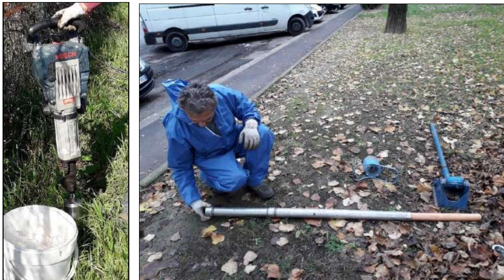
FIGURA 38 - DETTAGLI CAROTIERE MANUALE
